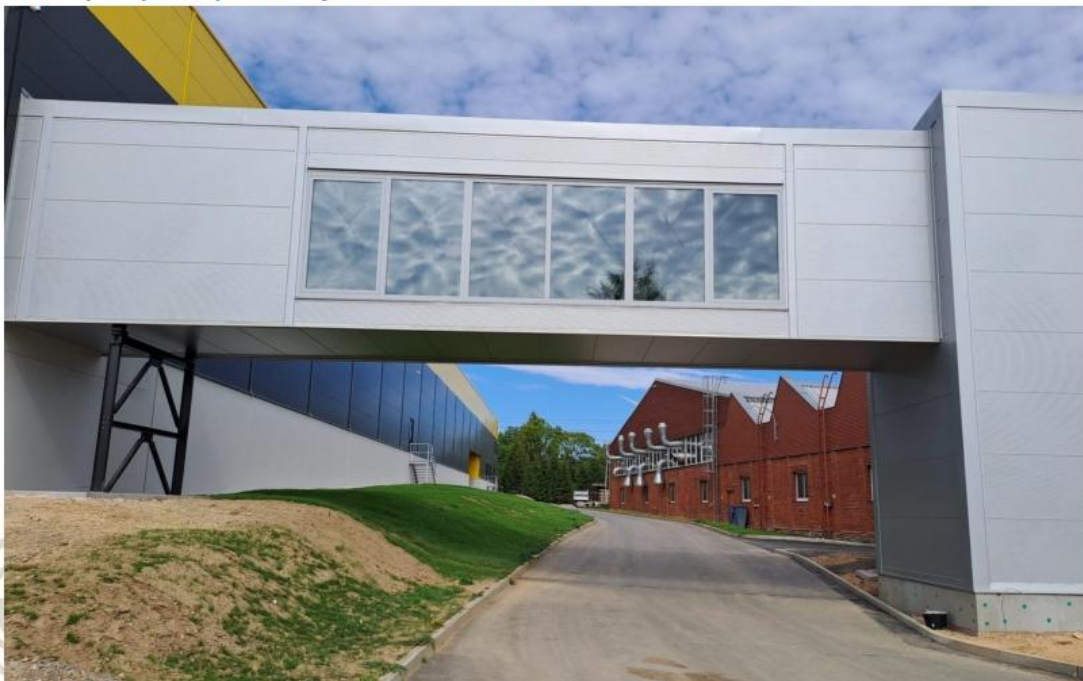
Pallet conveyor – primer povezivanja između dva skladišta
