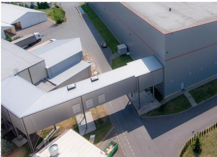
Pallet conveyor – primer povezivanja između dva skladišta
