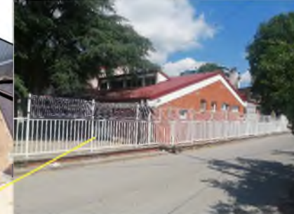
Поглед на објекат предшколске установе "Дуга", П+1
