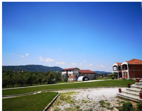
Објекти поред цркве (парохијски дом и помоћни објекат)
